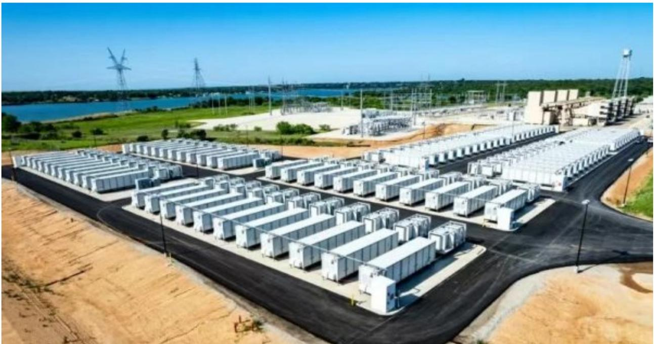
该项目主要建设装配储能电站，电站容量约200MW/400MWh、一期为100MW/200MWh，电池类型为磷酸铁锂电池，包含约400MWh锂电池集装箱储能，约200MW的PCS升压一体舱以及一座约110KV升压站。
